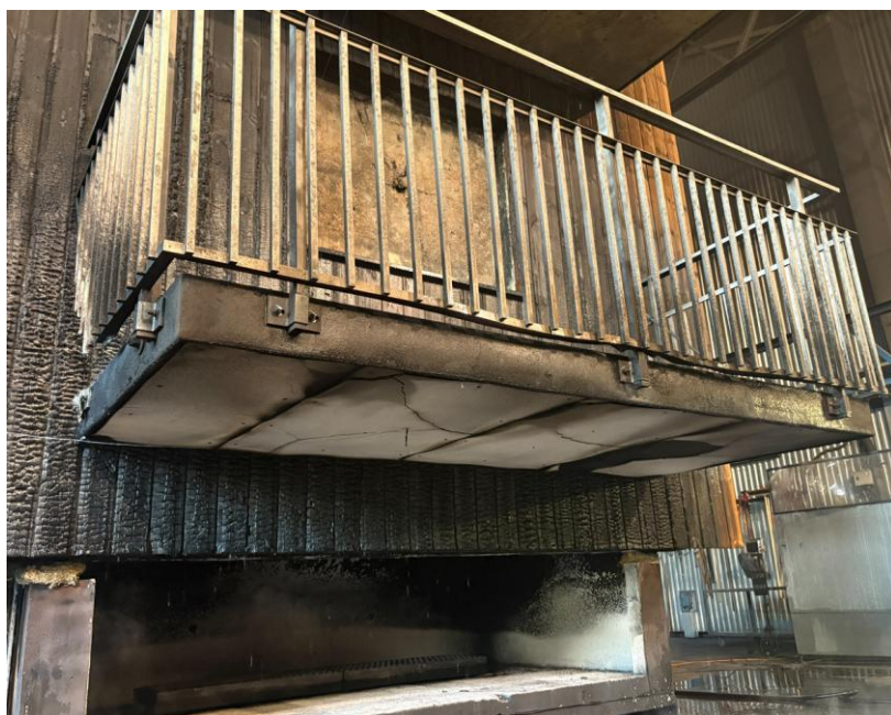
Figur 15. Bild på undersidan av den nedre balkongplatta efter prov. Fibercementskivan har spruckit på ett antal ställen men sitter kvar.
