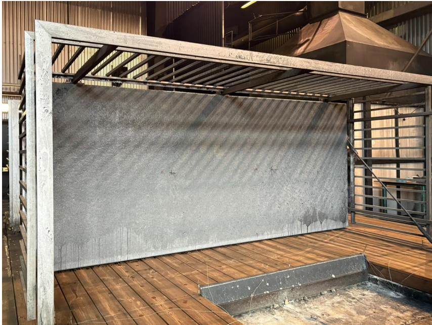
Figur 17. Bild på ovansidan av den övre balkongen efter prov. Både balkong och panel är oskadade.
