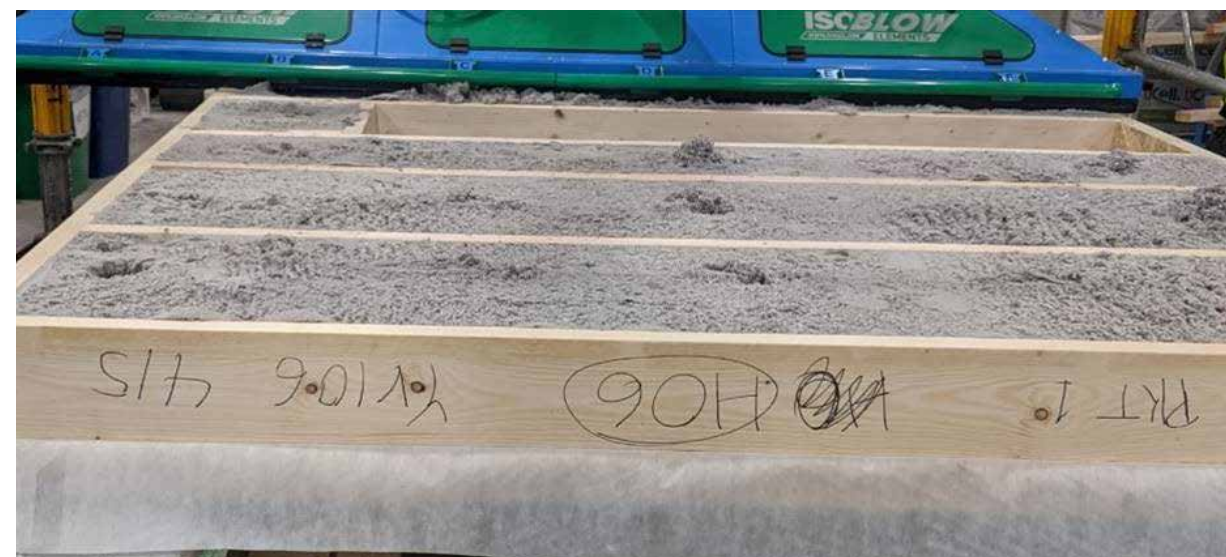
Test av bioisolering i väggelement.
