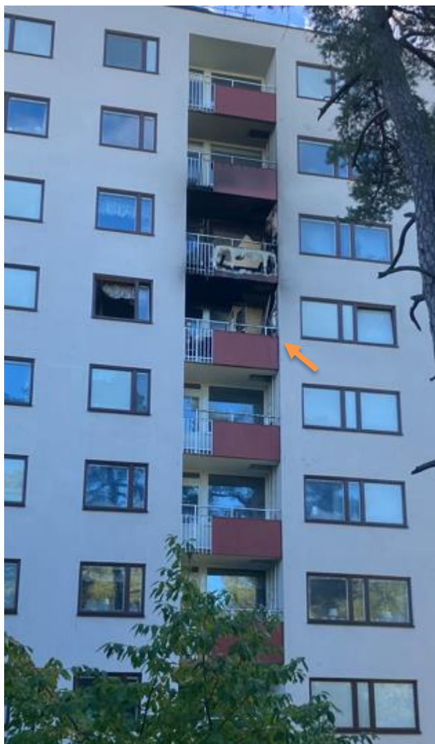
Figur 2. Balkong på brandutsatt lägenhet i mitten. På bilden syns utrymningslucka, stege och utförande av balkongräcke. Orange pil visar balkongen där branden startade.
