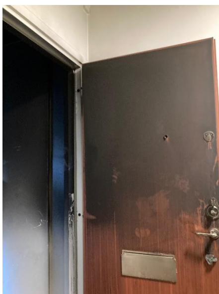
Bild 4 och 5. Lägenhetsdörren har varit tät.
