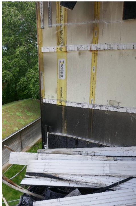
Figur 14. Läkt och fasadskiva bakom fasadpanelen.
