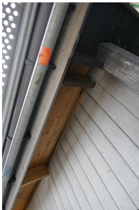
Figur 16. Den del av takfoten som är utförd öppen har i aktuellt fall inte påverkats av branden.
