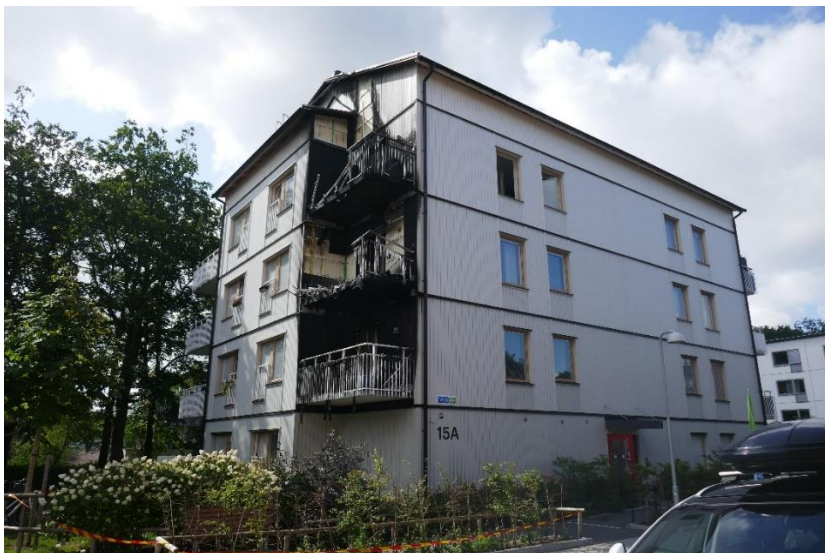
Figur 3. Utvändiga brandskador. Delar av balkongräcken på plan 3 och 4 fanns inte kvar.
