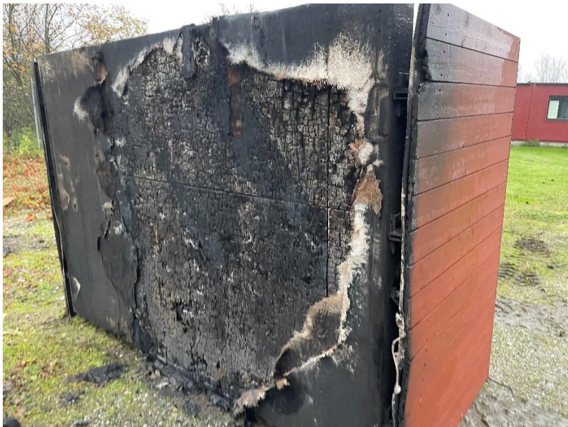
Figur 24. Undersidan balkongplatta. Kompositmaterialet lossnade delvis och trät bakom blev brandskadat.
