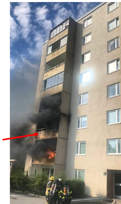
Bild 2. Branden har spridit sig från startbrandplatsen på balkongen på 2:a våningen (där pilen pekar) till balkongen under på 1:a våningen
