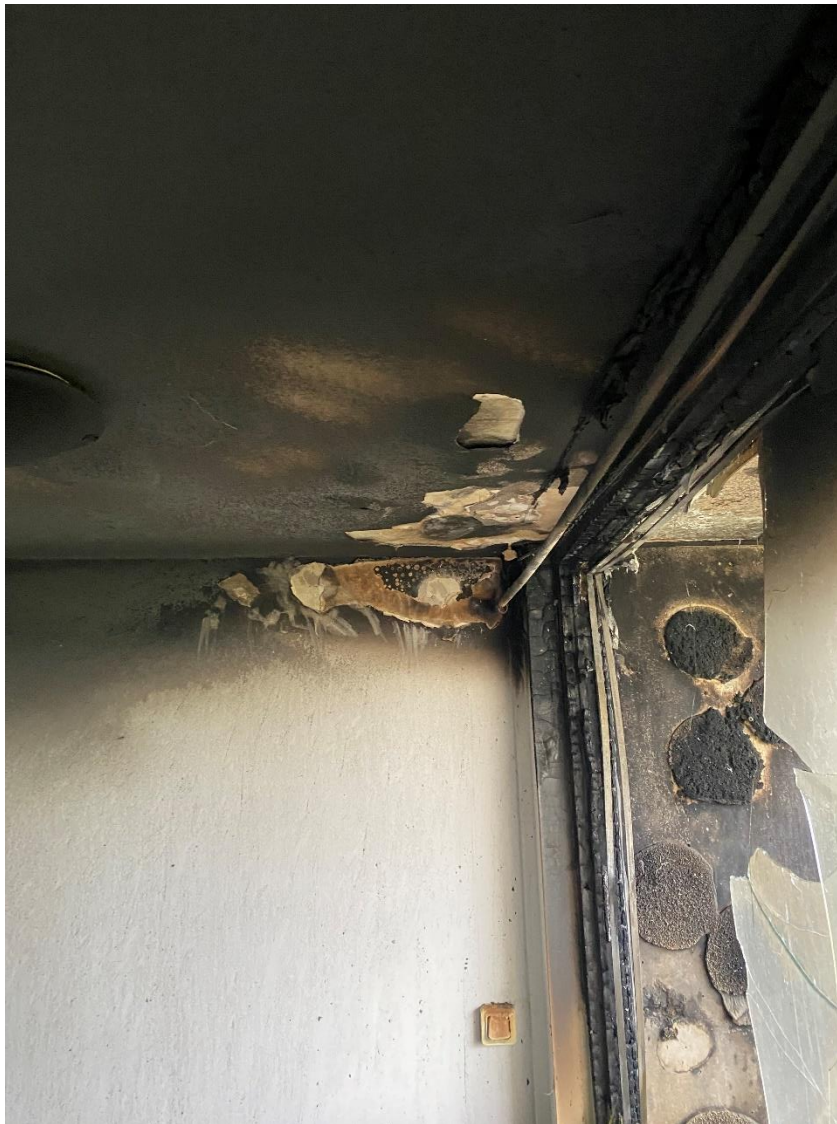
Figur 5. Innanför balkongfönster på brandvåning.
