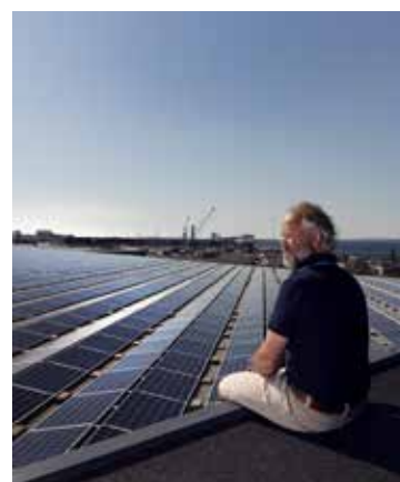
Solceller på vårt fabrikstak vid Haraholmen utanför Piteå.
